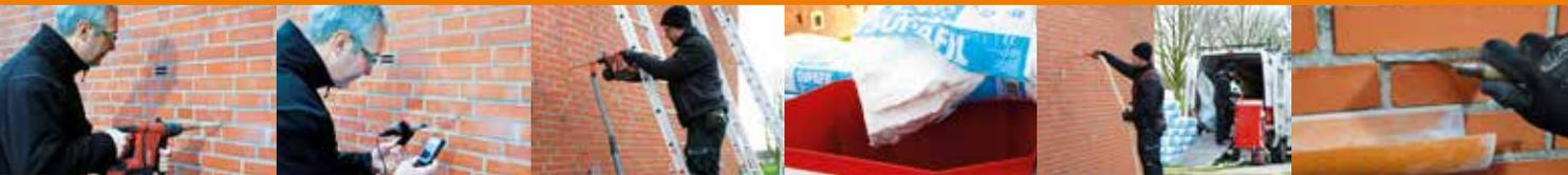
Mit einer Probebohrung wird der Wandzwischenraum untersucht und die mögliche Dicke der Dämmschicht ermittelt. Über kleine Löcher in der Fassade wird Knauf Insulation Supafil Cavity Wall durch Schläuche und Düsen in den Hohlraum eingeblasen.
